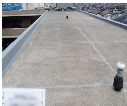
ビル / 屋上駐車場
